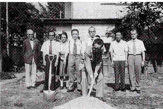
全断連本都会館起工式 （昭和52年4月 東京都豊島区目白）
